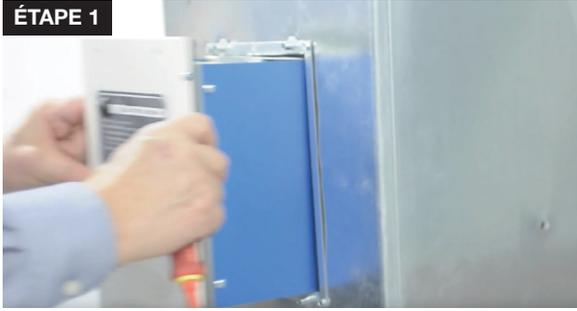
1. Retirez le UVC+ AIR du conduit de ventilation en enlevant les 4 vis situées sur le couvercle (aux 4 coins) et qui le maintiennent sur le cadre.
