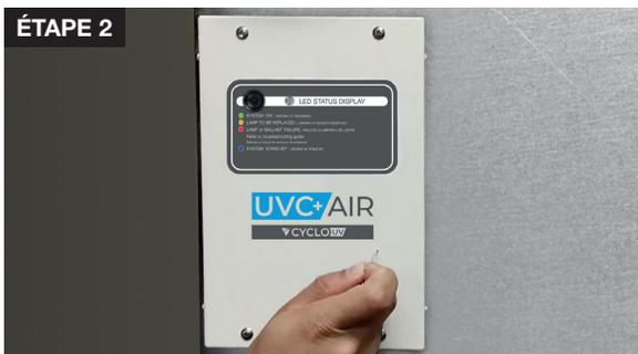
2. Utilisez un petit objet comme un trombone et insérez-le à l'intérieur du trou de réinitialisation, afin de pouvoir appuyer sur le bouton de réinitialisation.
