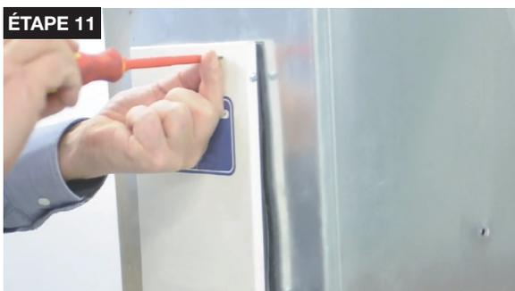
11. Fixez le UVC+ AIR au cadre à l'aide des 4 vis de fixation situées aux 4 coins de l'unité sur le couvercle.
