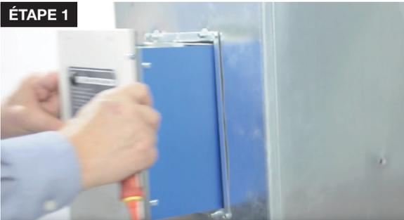
1. Retirez le UVC+ AIR du conduit en enlevant les 4 vis situées sur le couvercle (aux 4 coins) et qui le maintiennent sur le cadre.
