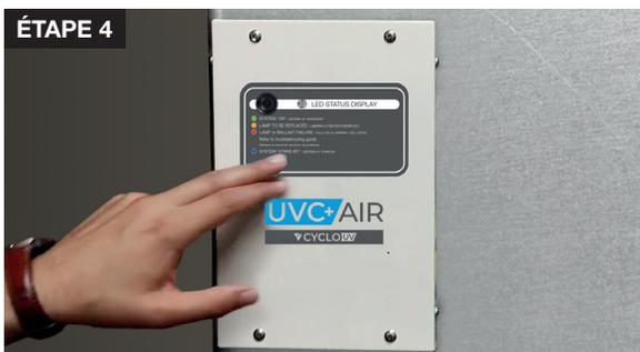
4. À partir de maintenant, le UVC+ AIR s'activera uniquement lorsque le thermistor détectera un flux d'air dans votre système de climatisation.
