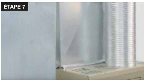
7. Préparez le conduit pour l'installation (retour ou entrée d'air). Vous devez trouver l'endroit le plus approprié pour installer l'unité. La chambre de réflexion doit toujours être parallèle au flot d'air. Assurez-vous d'avoir assez d'espace dans le plenum pour accueillir l'unité et que dans la position choisie l'exposition des composants en plastique situés dans le plenum soit minimisée.
