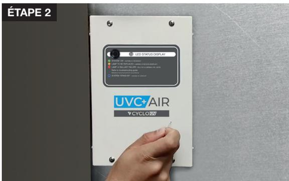
2. Utilisez un petit objet comme un trombone et insérez-le à l'intérieur du trou de réinitialisation, afin de pouvoir appuyer sur le bouton de réinitialisation.
