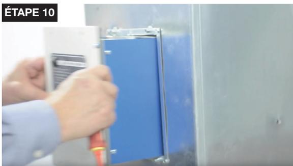
10. Terminez l'installation du UVC+ AIR en le plaçant dans le cadre, guidé par les goupilles de positionnement.
