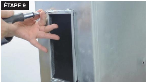
9. Placez le cadre dans l'ouverture faite dans le conduit et utilisez les 6 vis métalliques fournies dans le kit d'installation pour le fixer sur le conduit. Utilisez de préférence les 3 trous en haut et 3 en bas pour insérer les vis.
